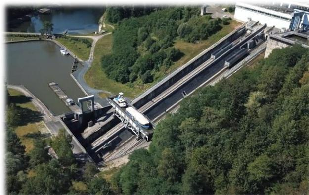
Situé sur le canal de la Marne-au-Rhin au Pays de Phalsbourg, il permet aux plaisanciers de franchir le seuil du Massif Vosgien en rattrapant un **dénivelé de 44,55m en quelques minutes.**
